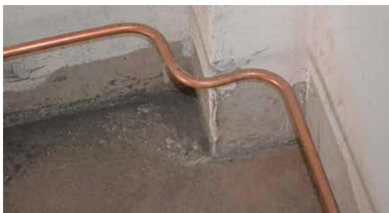
Equipotential grounding conductor
